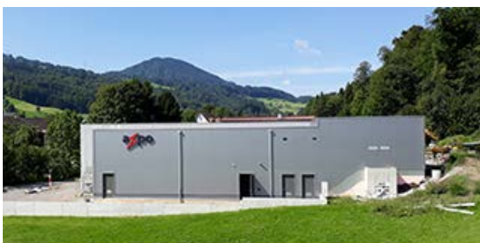
Image 12 : Poste électrique d'Etzel d'Axpo dans les Alpes suisses
