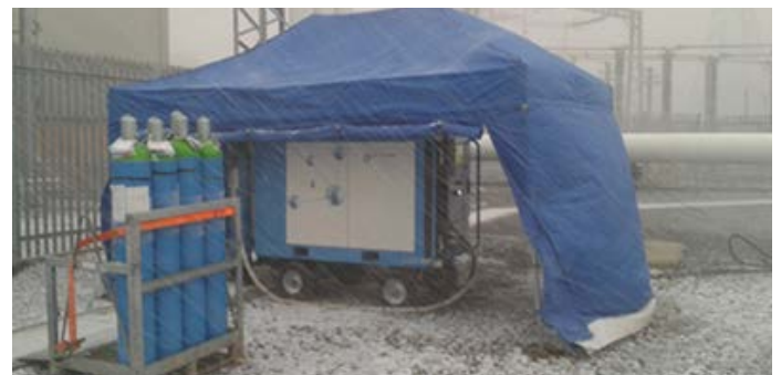
Image 11 : Opération de remplissage du g 3 dans la ligne à isolation gazeuse 420 kV au poste de Kilmarnock de Scottish Power, Royaume-Uni
