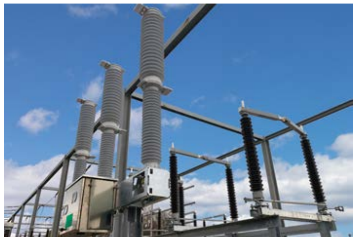
Image 3 : Disjoncteur de type Live Tank 145 kV sans SF_6 , utilisant la place le gaz g^3 de GE
