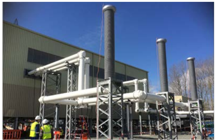
Image 2 : Ligne 420 kV isolée au g^3 sur le réseau de National Grid, au poste de Sellindge au Royaume-Uni.
